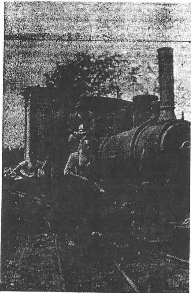
La locomotive Decauville à vapeur et la file de wagonnets chargés chacune d'une tonne et demie de quartzite.
